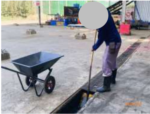
รูปที่ 22 การขุดลอกรางระบายน้ำในพื้นที่โครงการ
