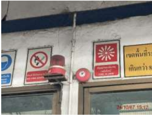
รูปที่ 33 ระบบแจ้งเหตุเพลิงไหม้/ระบบเตือนภัย
