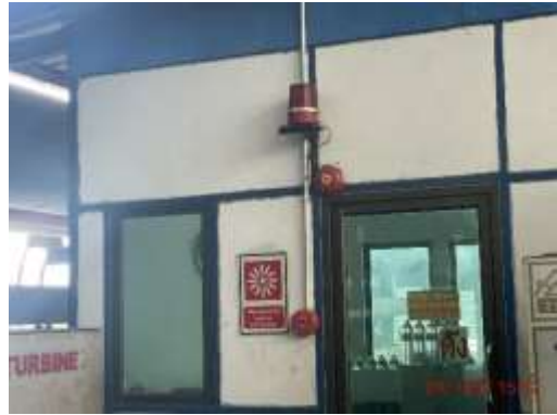
รูปที่ 33 ระบบแจ้งเหตุเพลิงไหม้/ระบบเตือนภัย
